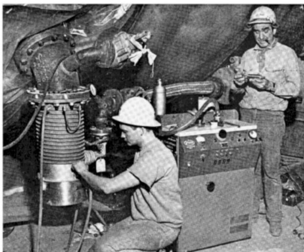
**Рис. 6.** Весь бак целиком был проверен на герметичность инженерами компании "Чикаго Бридж энд Айрон". Емкость и подводящие трубы помещались в гелиевую среду. К вакуумному насосу, который откачивал воздух из емкости, был подсоединен небольшой высокочувствительный масс-спектрометр. (*Острые грани*, сентябрь 1966 г.)
