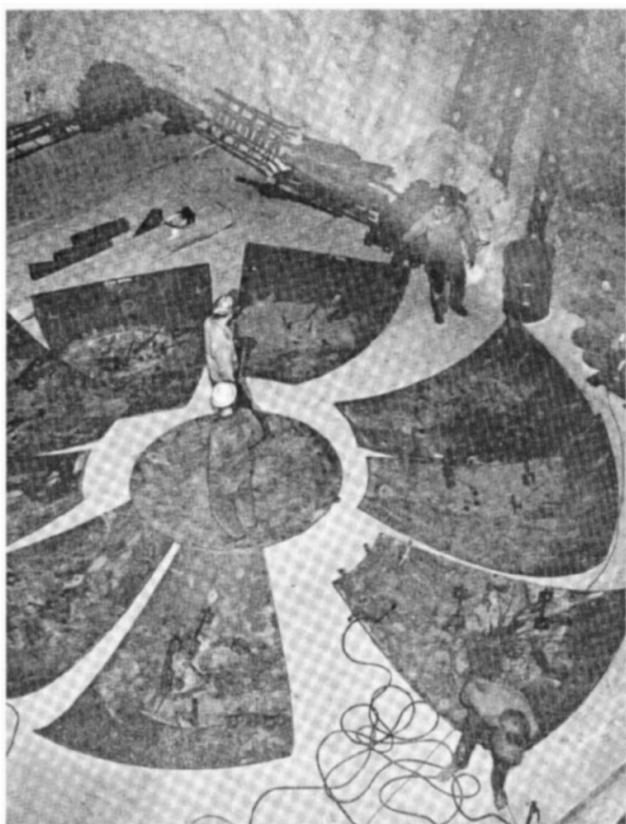
Рис. 4. Детали одного из торцов бака разложены на полу большой камеры. Из июня 1965 г. выпуска *Острых граней*.
