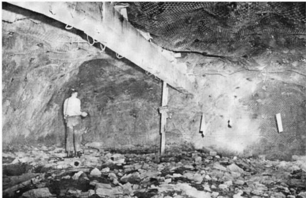
Рис. 3. Наполовину вырубленная большая камера для установки бака в шахте Хоумстейк (лето 1965 г.). Из сентябрьского 1965 г. выпуска бюллетеня *Острые грани*, издаваемого горнодобывающей компанией Хоумстейк.
